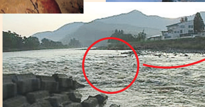
損傷した破間川右岸頭首工
