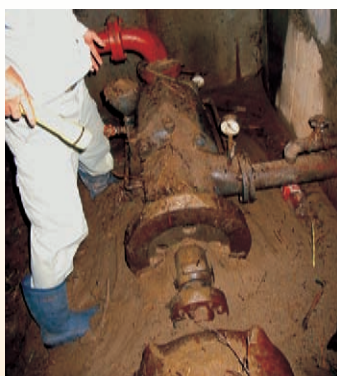
須原揚水機の損傷【須原】
